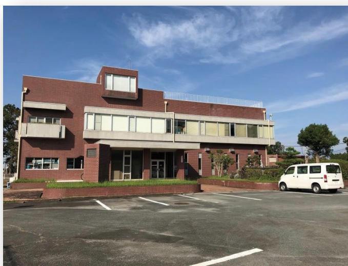
【中須水源地水道管理センター】
