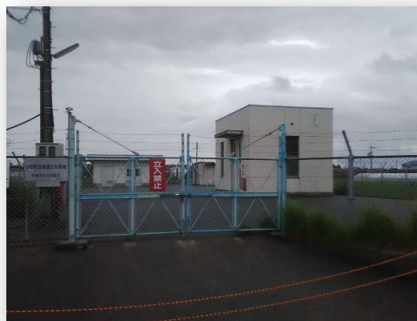
【宮前第2水源地】
