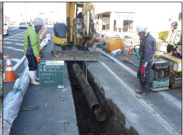
【老朽管撤去状況】
